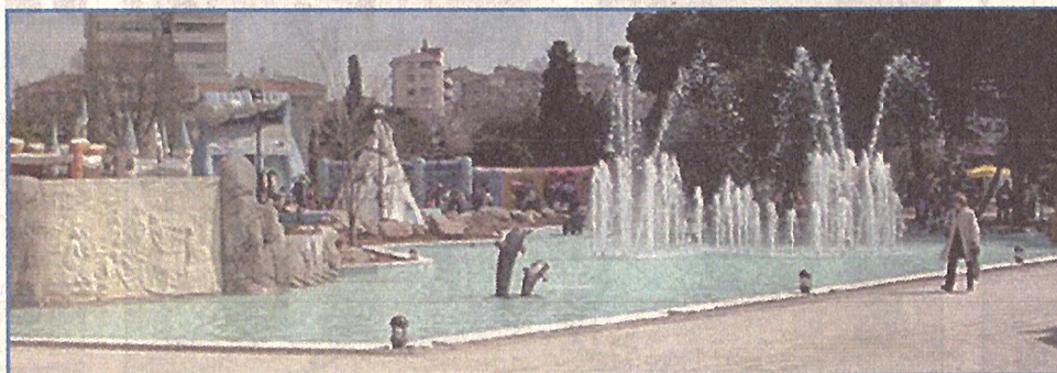
Son yapılan çalışmalar kapsamında fıskiyeli bir havuz da inşa edildi...
